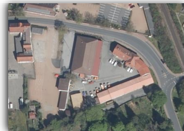
Abbildung 6: Betriebshof in Osterode, Quelle: Geoportal.de
